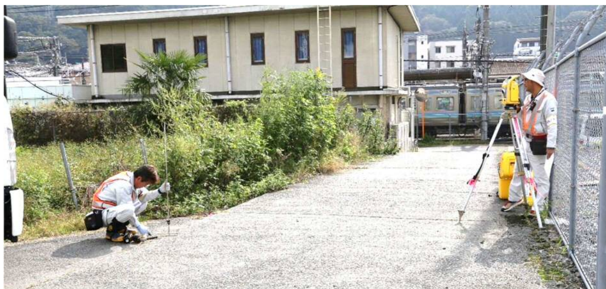
測量作業の様子
