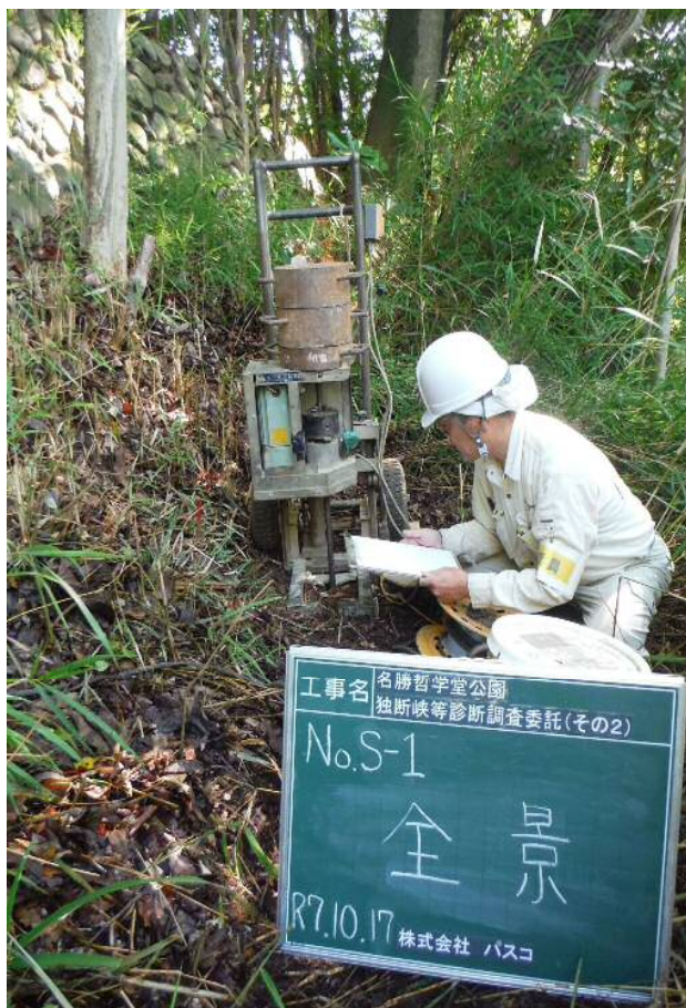
サウンディング（スクリューウエイト貫入試験）作業の様子
